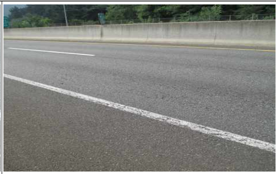
교면포장 상행선 S1 라벨링
