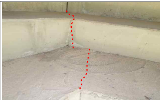
하행선 A2 콘크리트 법면 균열(폭 0.3mm)
