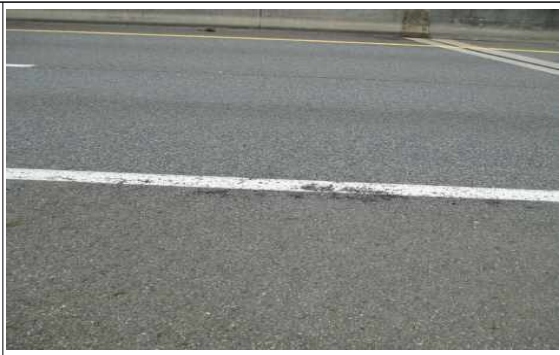
교면포장 상행선 S1 라벨링
