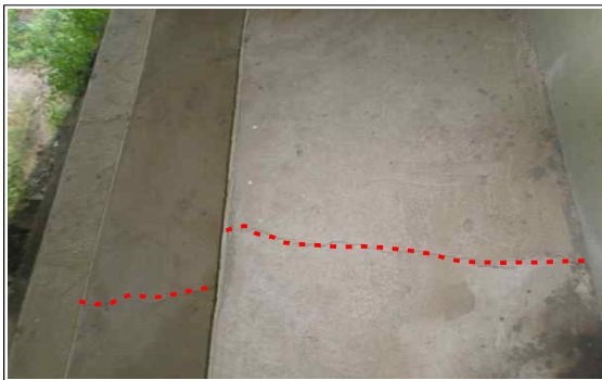
상행선 A1 콘크리트 법면 균열(폭 0.3~0.5mm)
