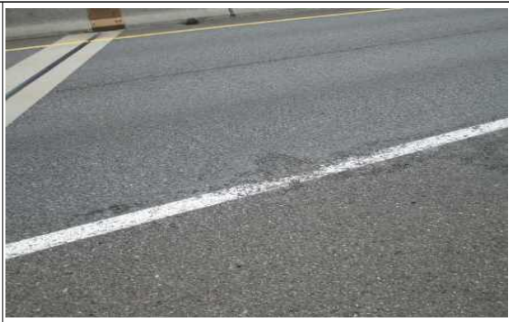
교면포장 상행선 S1 라벨링
